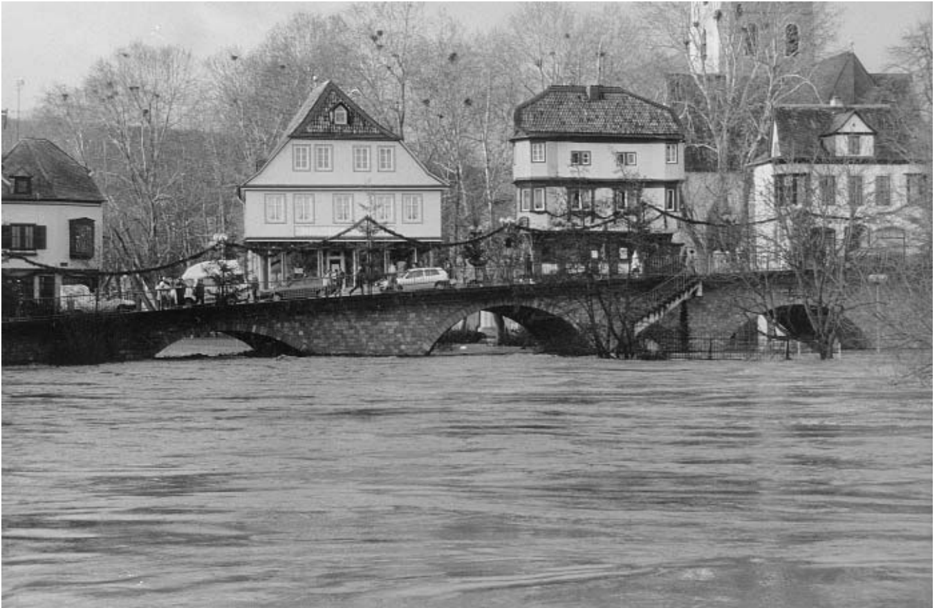
Die alte Nahebrücke - 1993
