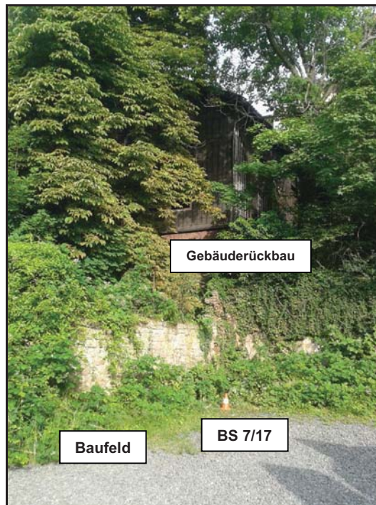
Foto 3 Blickrichtung nach Westen auf das Baufeld
