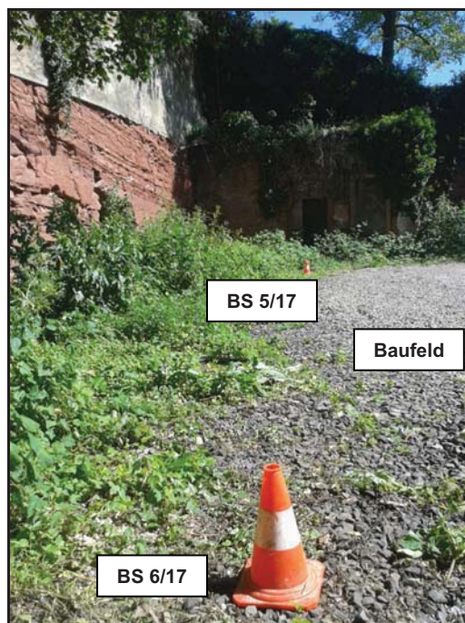
Foto 2: Blickrichtung nach NE auf das Baufeld
