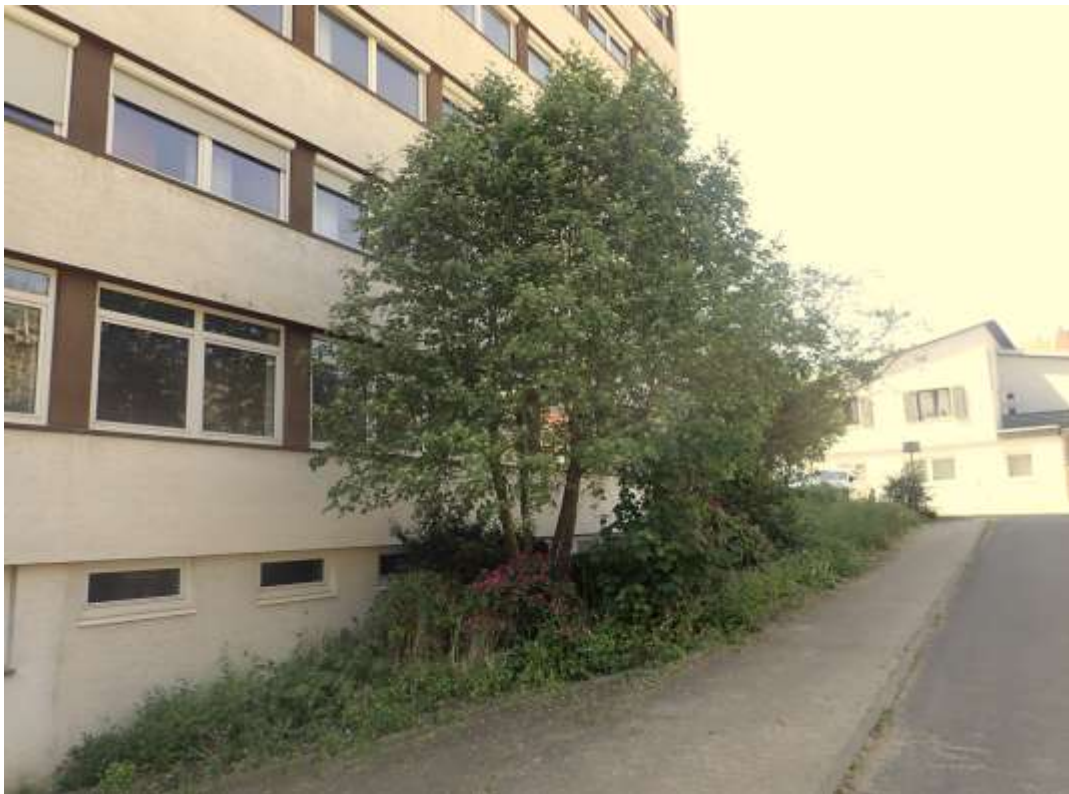
Bild 07: Die vorgelagerten Pflanz- und Zierbeete entlang des südlichen Gebäudes
