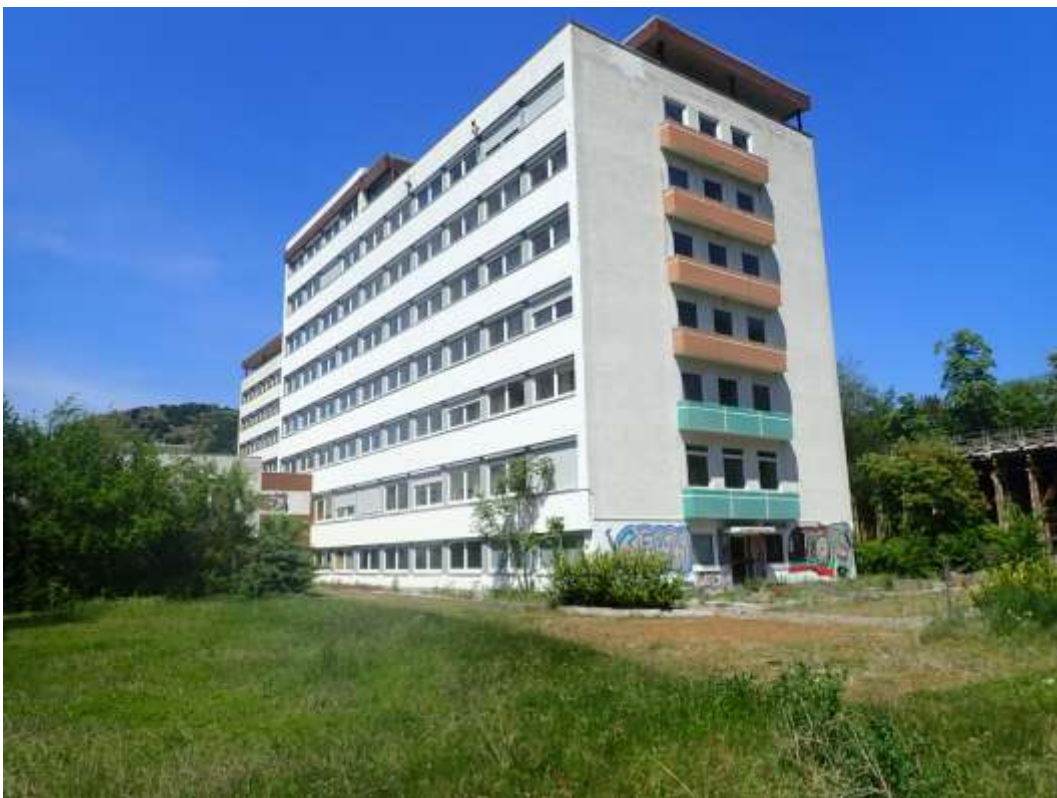
Bild 02: Die Südseite des alten Klinikgebäudes
