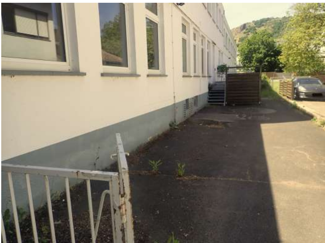
Bild 10: Asphaltierte Flächen östlich des nördlich gelegenen Gebäudes
