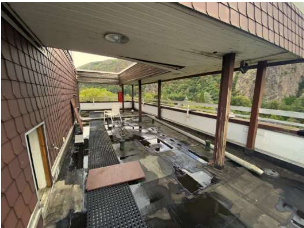
Bild 16: Das am südlich gelegenen Gebäude rückzubauende Element auf der ehemaligen Klinik, welches keine Vogelbruten aufwies
