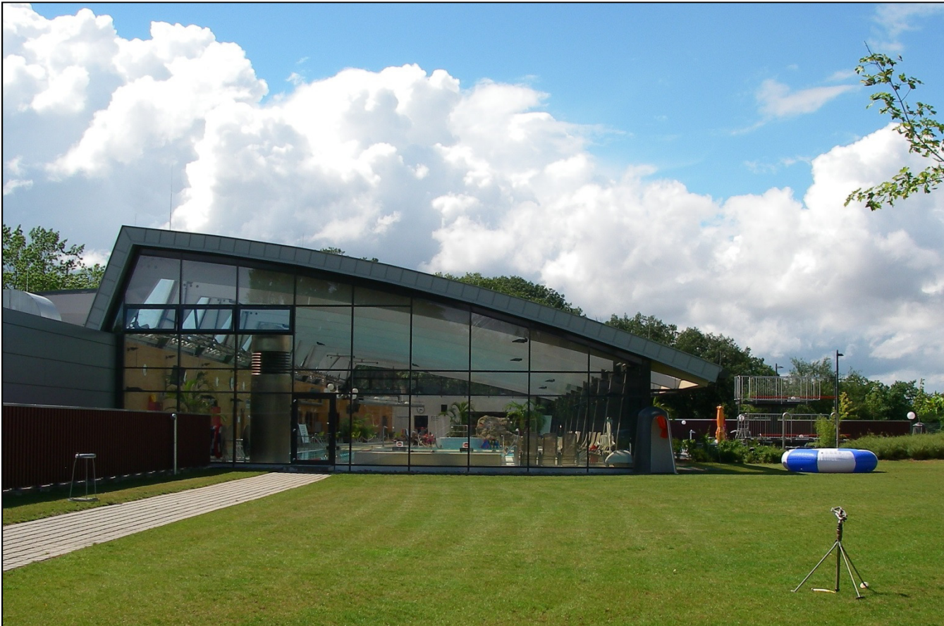
Abb. 40: Bsp. Außenansicht Hallenbadneubau auf Freibadgelände (Quelle: Sport- und Freizeitbad Kelsterbach)
