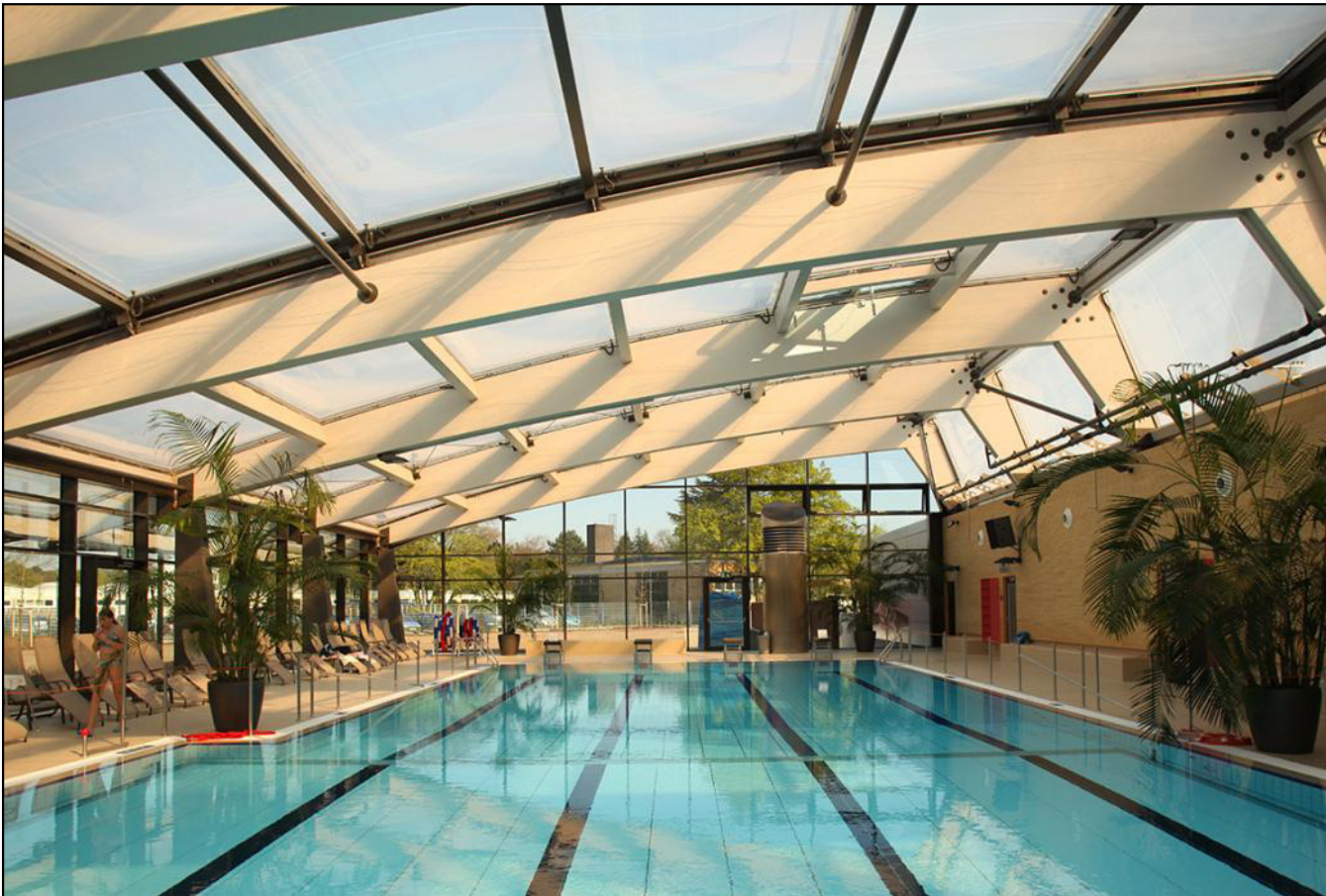
Abb. 39: Bsp. offene, lichtdurchflutete Konstruktion (Quelle: Sport- und Freizeitbad Kelsterbach)
