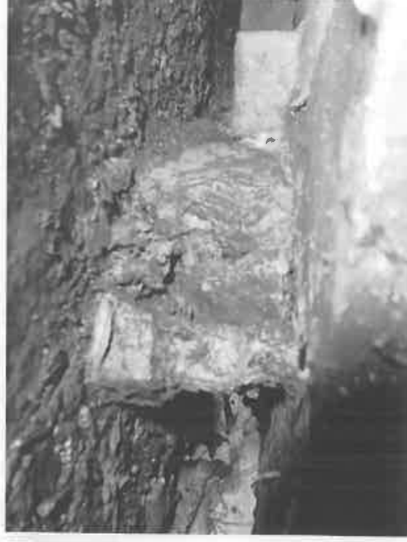
Haltebolzen -30% Querschnitt
