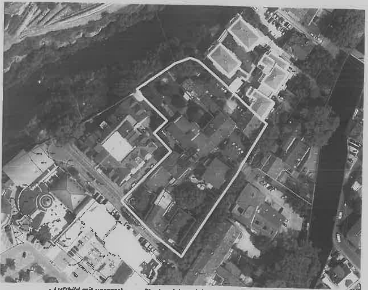
- Luftbild mit vorgesehendem Planbereich und der bisherigen Bebauungsstruktur -
