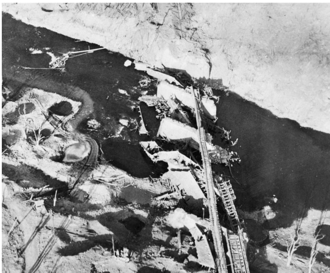
Die völlig zerstörte Bad Münsterer Eisenbahnbrücke. In der Mitte sind noch die Überreste des von der 12. SS-Eisenbaubrigade errichteten Gleises zu erkennen. Foto: Sammlung Rolf Schaller.
