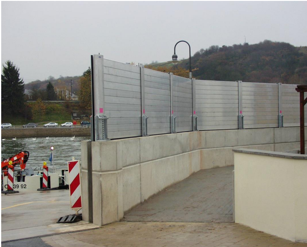
Hochwasserwand mit mobilen Elementen
