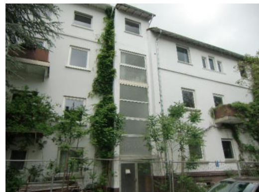
Abb. 21: Leerstehendes ehem. Hotel
