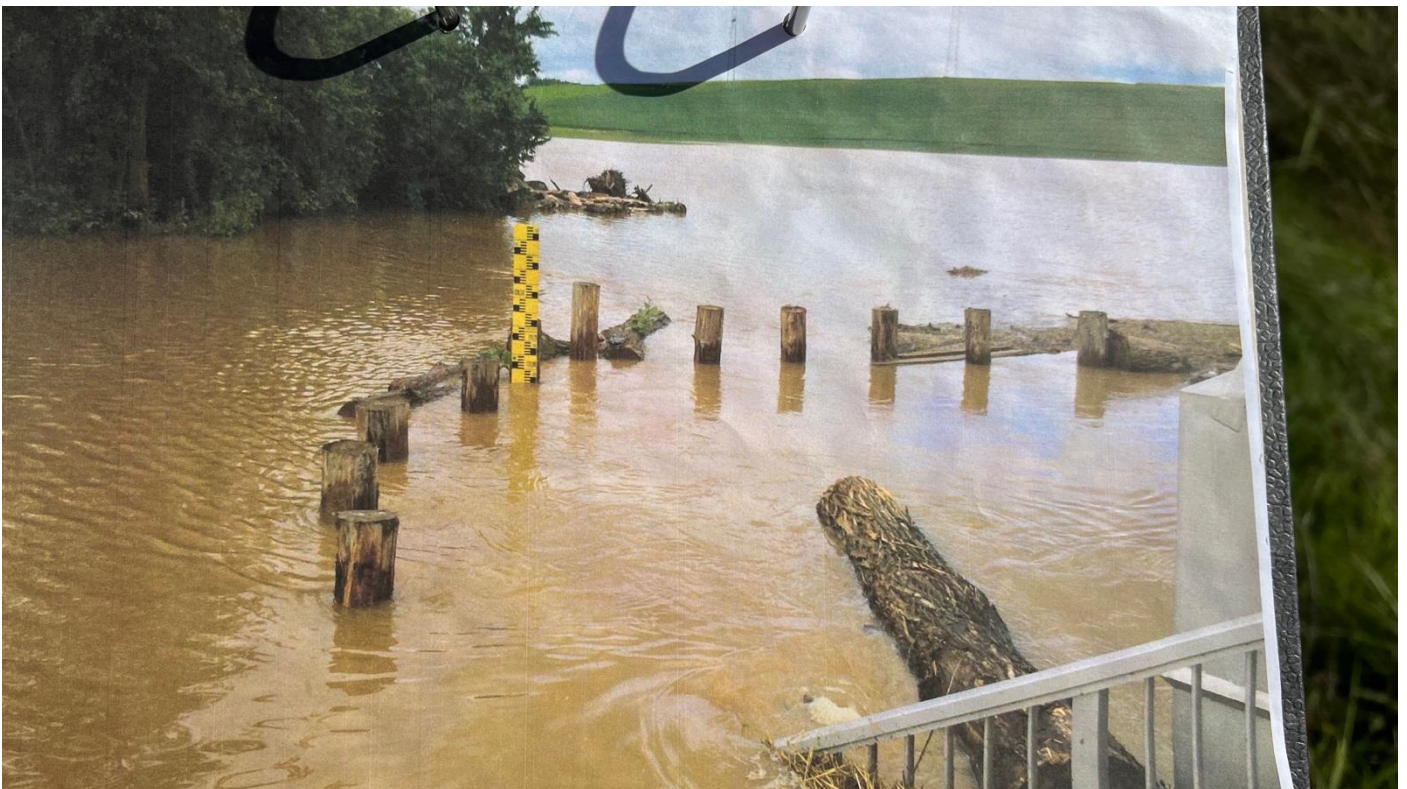
Abbildung 10: Treibgutsperre Polder Badenheim während Hochwasser bei der Baudurchführung (Quelle: Ulrich Deveaux (UWB))
