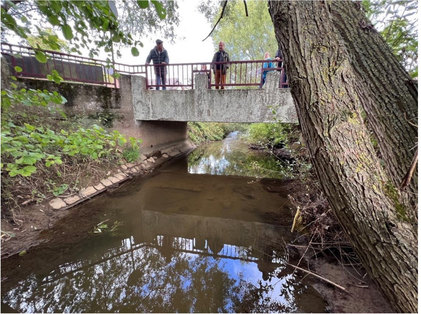
Abbildung 14: Appelbachbrücke September 2022 (Quelle: Heinrich Webler 19.09.2022)
