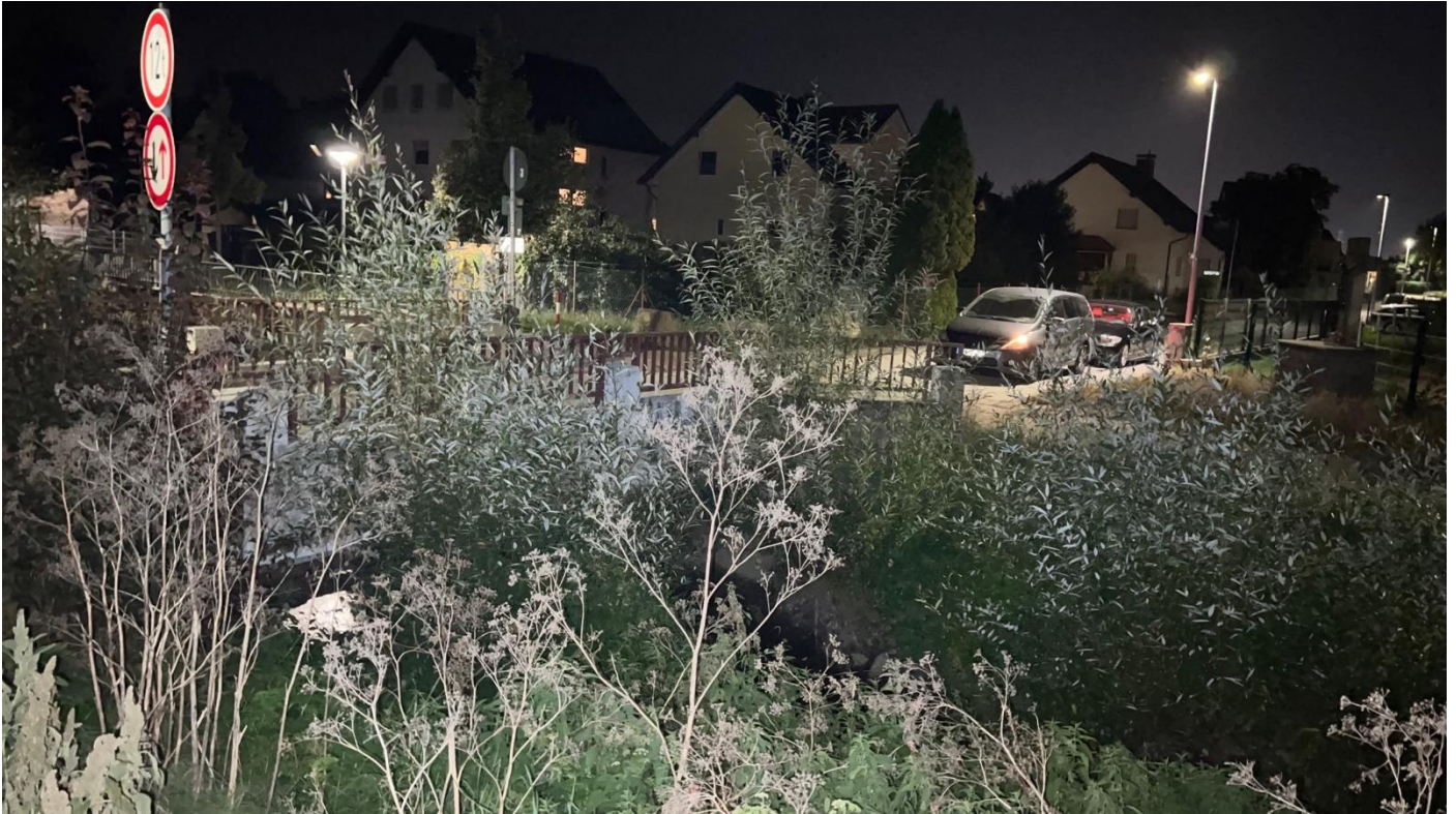
Abbildung 26: Zustand der Brücke am 11.09.2023, (Quelle: Heinrich Webler am 11.09.2023)
