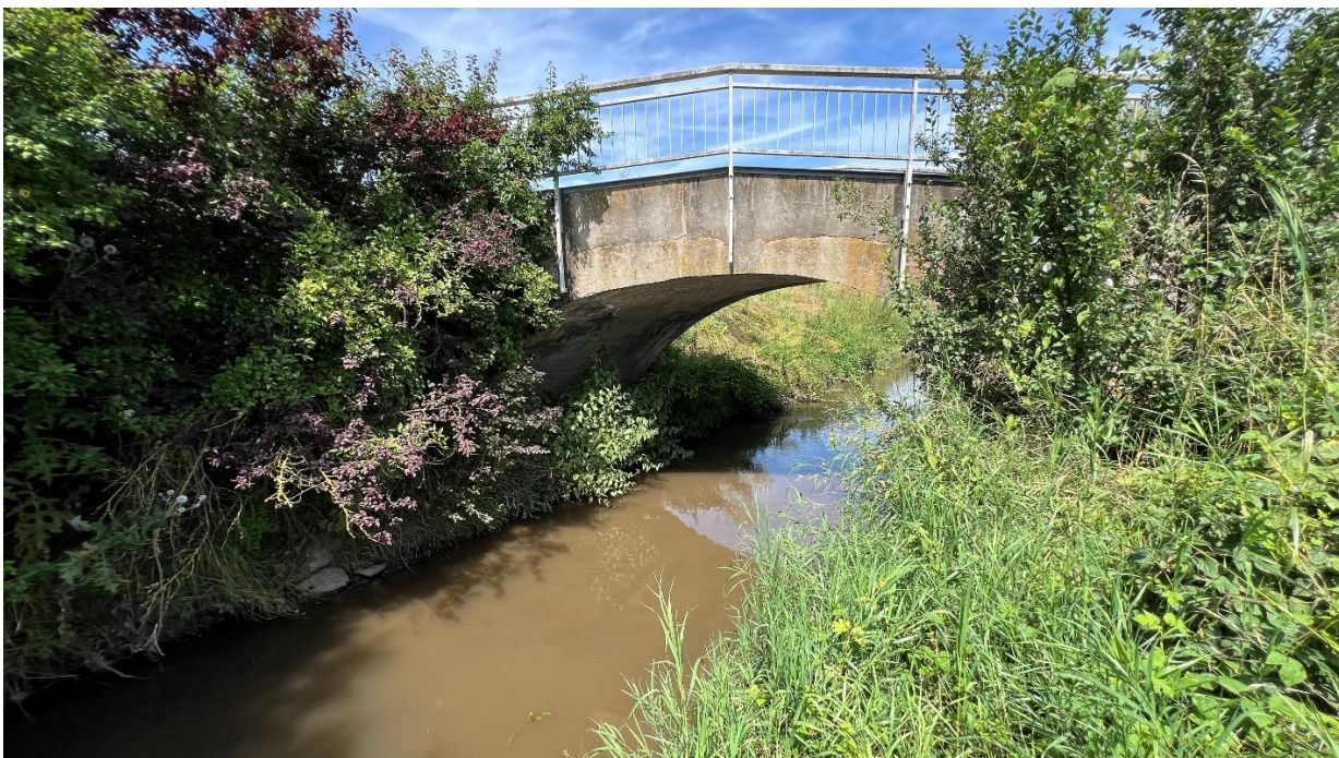
Abbildung 36: Brücke über den Appelbach am Polderdeich
