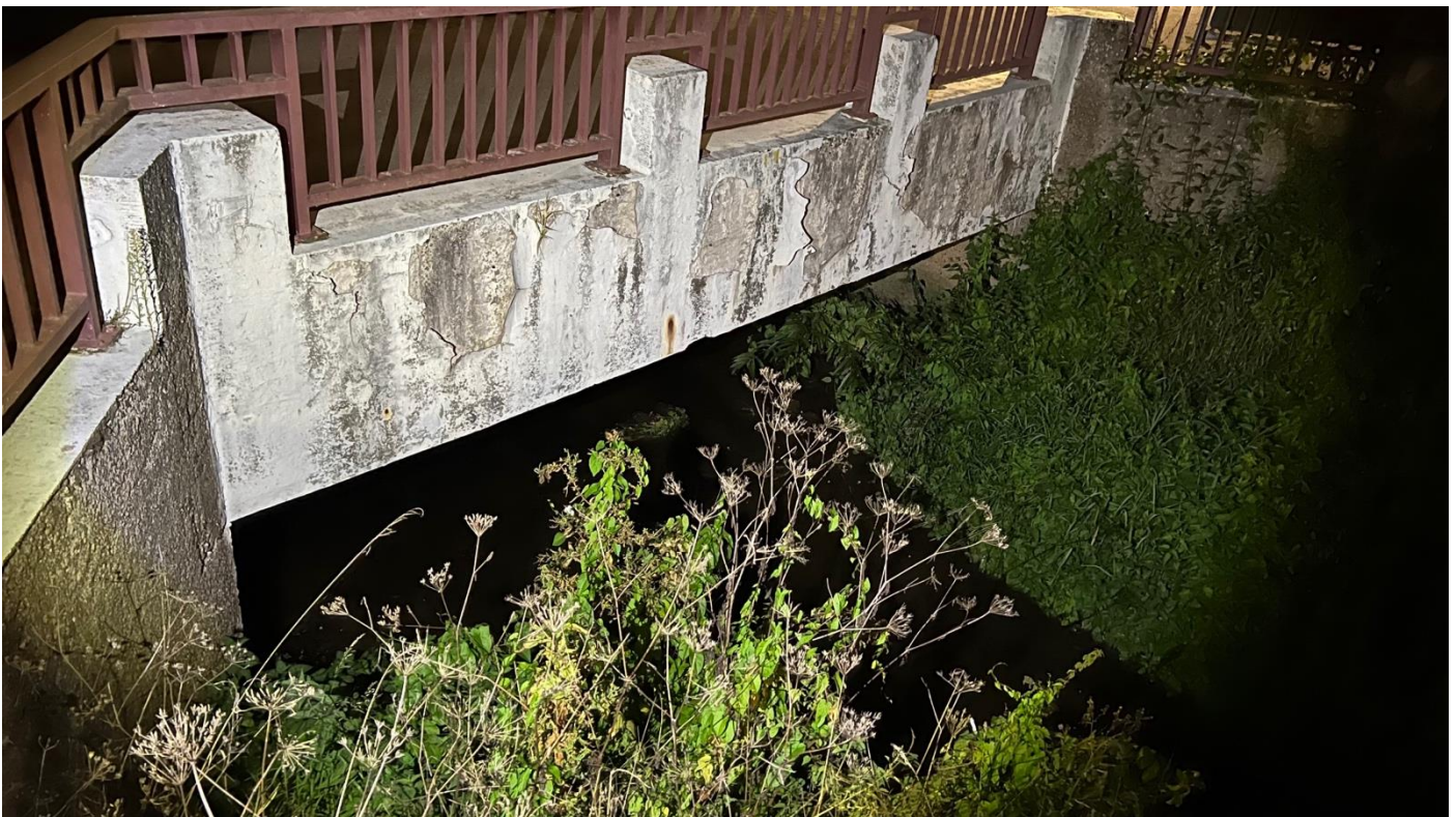
Abbildung 25: Zustand der Brücke am 11.09.2023, (Quelle: Heinrich Webler am 11.09.2023)
