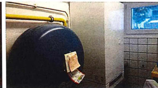
Heizung Gasbrennwerttherme ca. 15 Jahre alt
