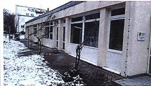
Dämmung Stützen WDVS nicht ausreichend
