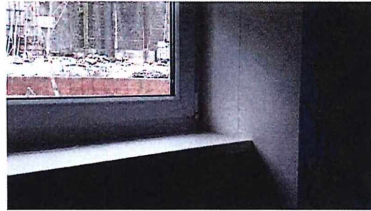
Kondensat am Fensteranschluss
